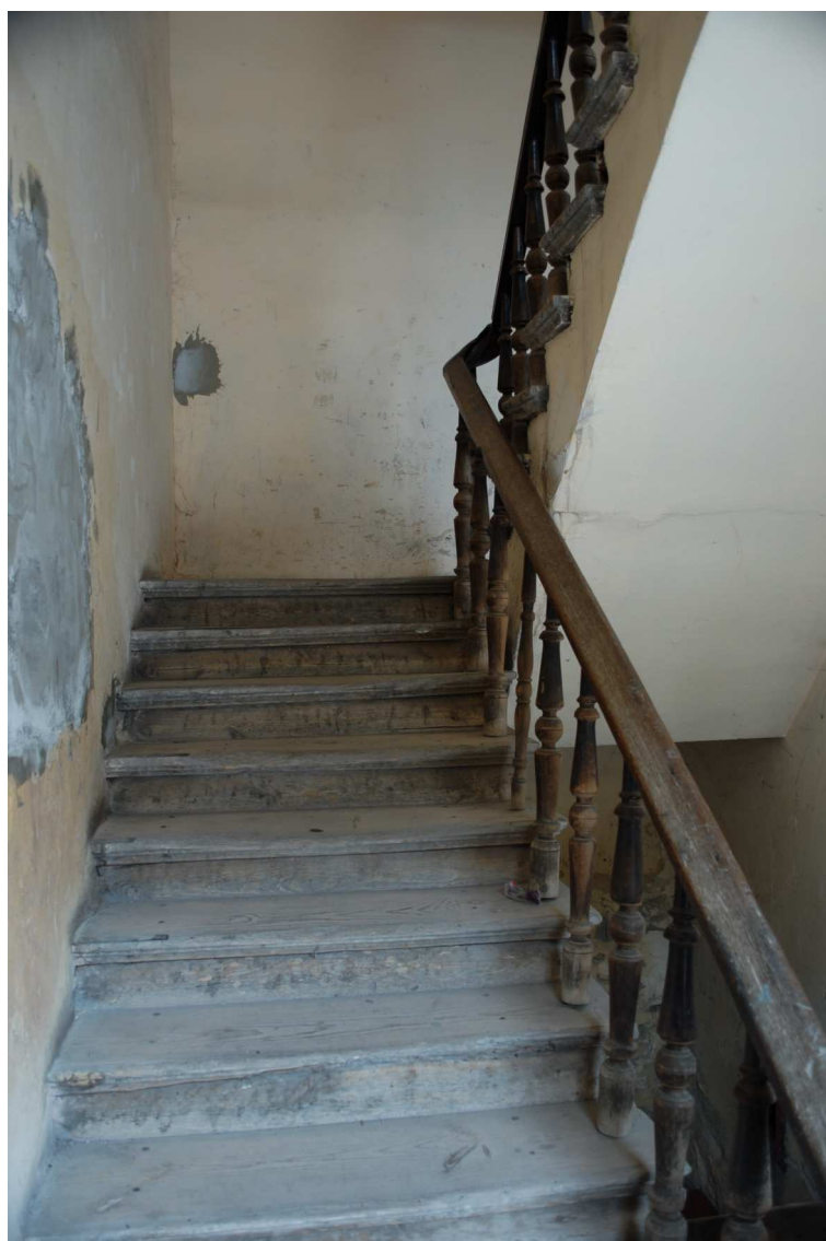
Klatka schodowa, Rybna 13, fot. Piotr Sztajdel, 2010.
