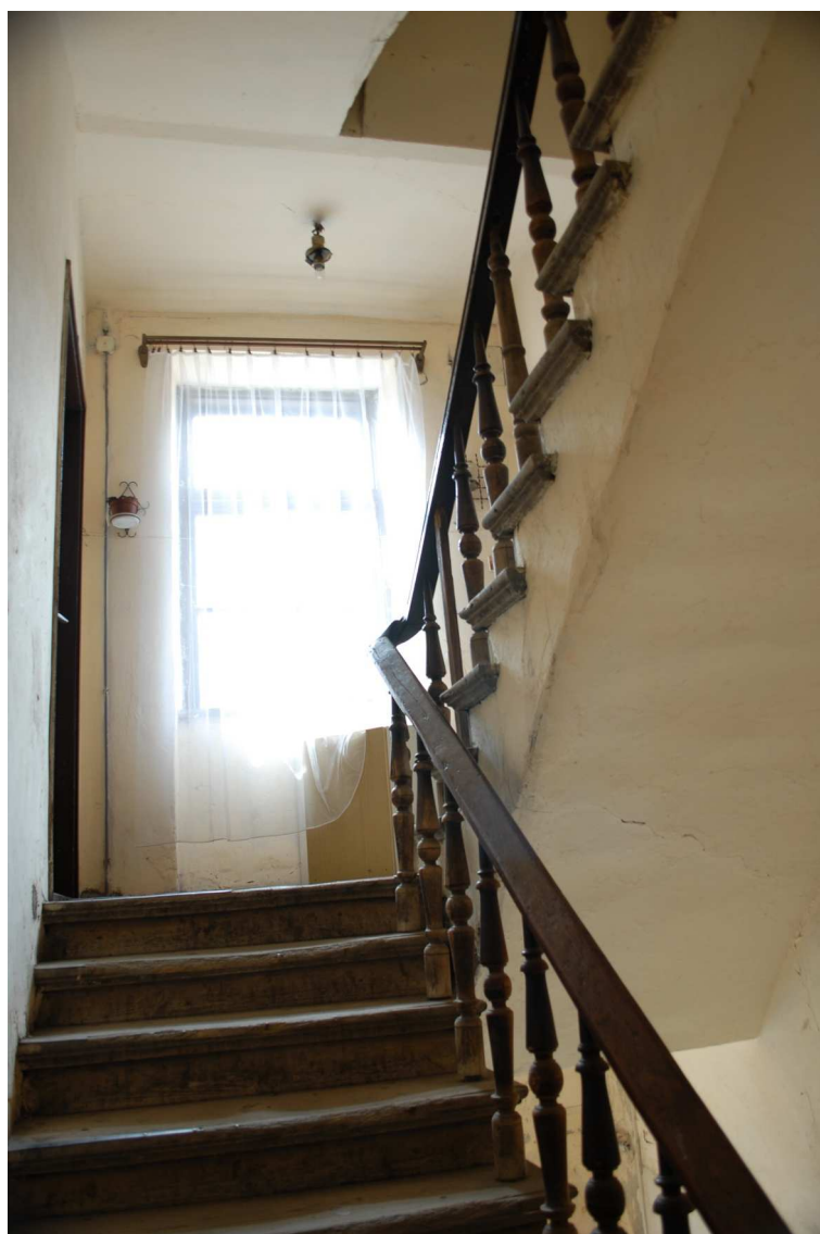
Klatka schodowa, Rybna 13, fot. Piotr Sztajdel, 2010.
