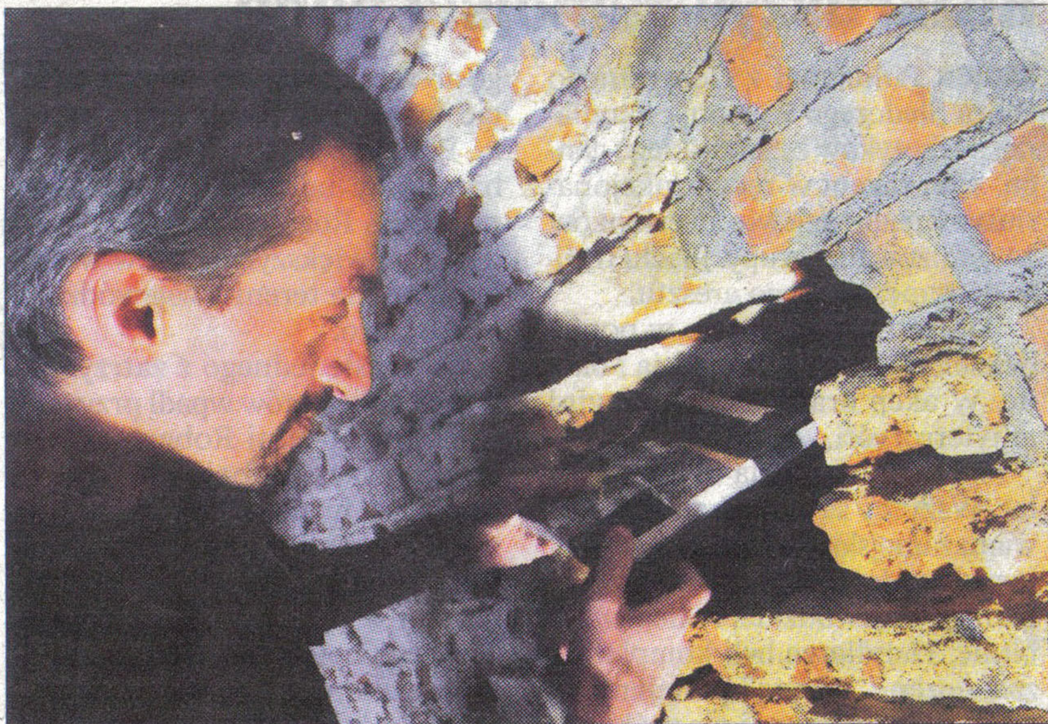
PRZESŁANIE TRAFIA DO SKRYTKI
