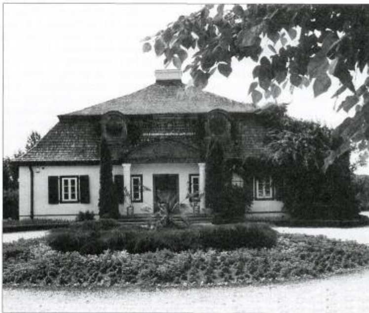
Elewacja frontowa dworu z gazonem i podjazdem, sierpień 2000 r.
