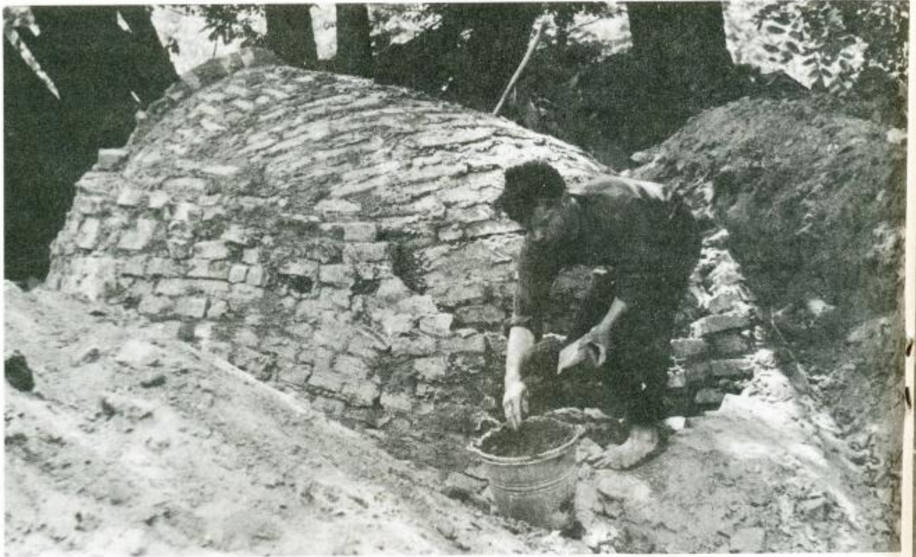
Baranów (woj. lubelskie). Remont pieca garncarskiego Fot. A. Gauda
