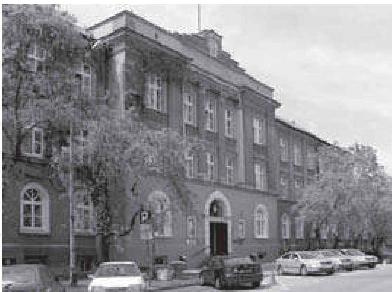
Powojenny budynek Urzędu Wojewódzkiego przy ul. Spokojnej. Fot. M. Skrzypek.
