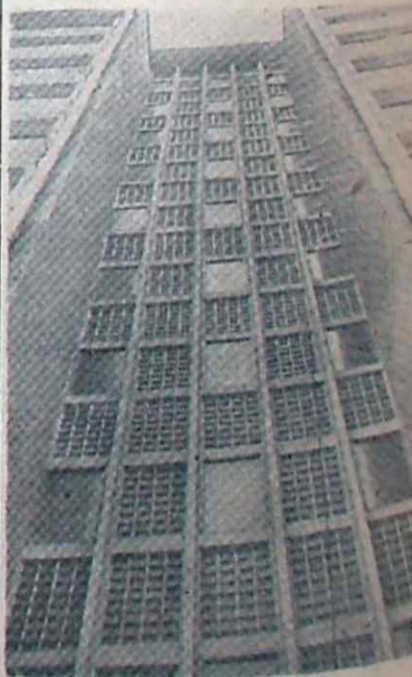
Klatka schodowa ostatniego z czterech punktowców przy ul. Unickiej.
