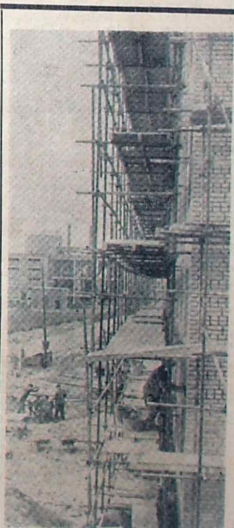
Bronowice II — Z prawej strony rusztowania na bloku nr 9, w głębi kotłownia dla całego osiedla (v. art. J. Dostatniego)
