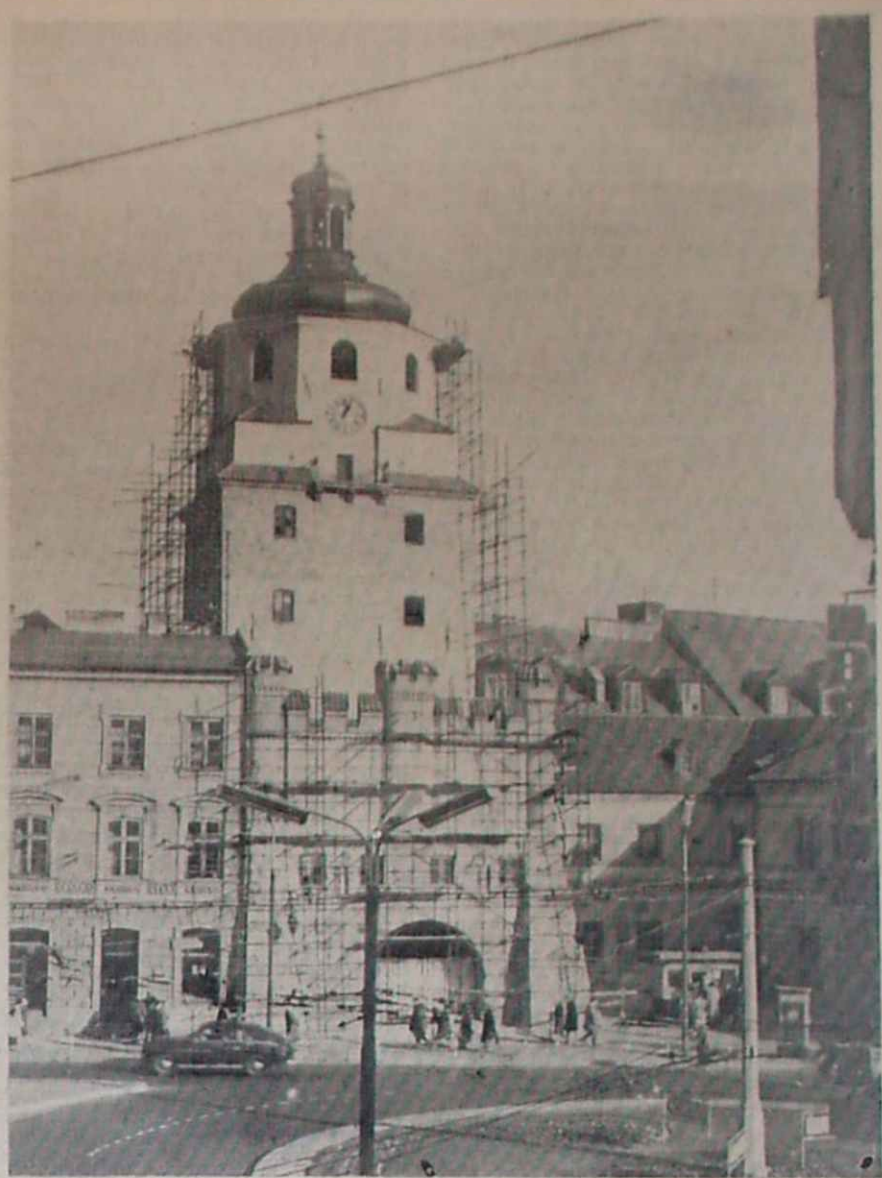
Brama Krakowska — budowla powstała w drugiej połowie XIV wieku ulegała zniszczeniom i kolejnym przekształceniom, ale mimo to zachowała swój zasadniczy gotycki charakter. Obecnie, w trakcie odbudowy i adaptacji dla potrzeb muzealno-turystycznych, Brama otrzymuje postać ujawniającą jej historię i wartości architektoniczne.
