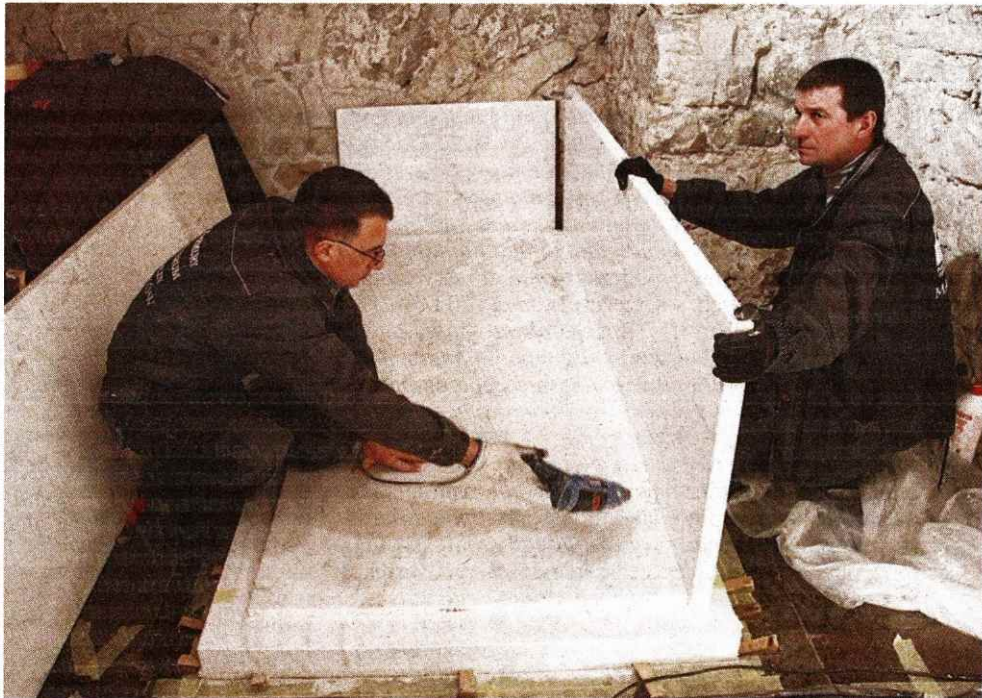
Wczoraj pracownicy firmy kamieniarskiej montowali ściany boczne sarkofagu
