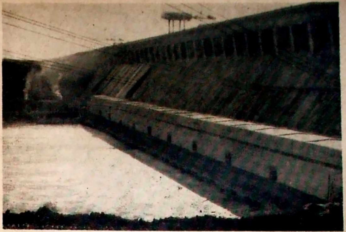
126-metrowej wysokości zapora przegradziła koryto Angary. U podnóża tamy — hala generatorów największej obecnie na świecie elektrowni wodnej, o mocy 4500 MW.
