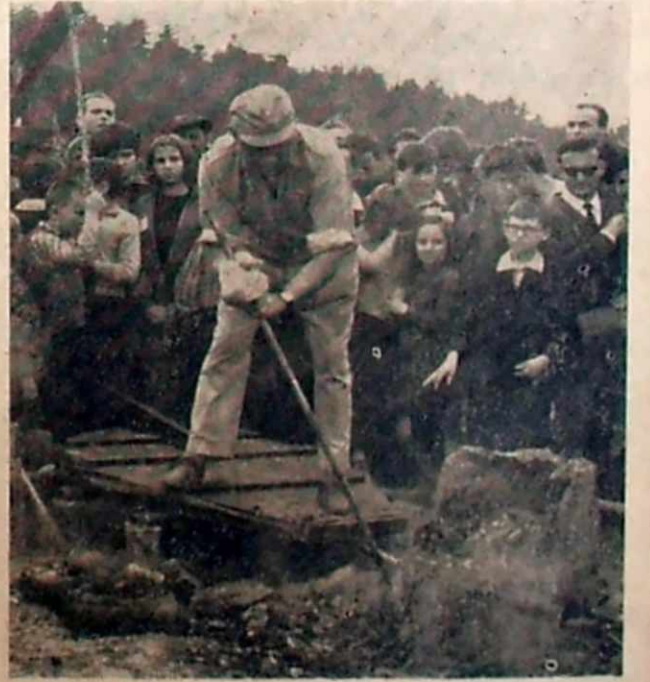
Dr Bielenin z AGH w Krakowie, jeden z inicjatorów „Dymarek” rezbijał piec dymarski, z którego wyjmują się następnie stop. Stop ten byłby następnie poddawany obróbce ręcznej przez kowali. Odbijali oni go młotami, żeby uzyskać czysty metal.
