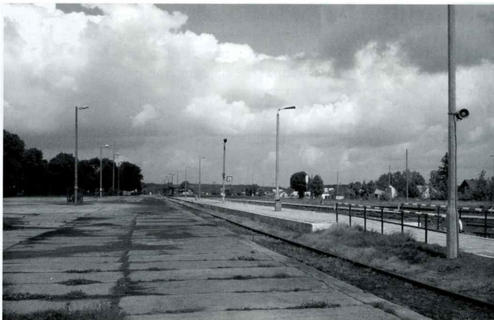
הרציף בתחנת הרכבת בלז'ץ
