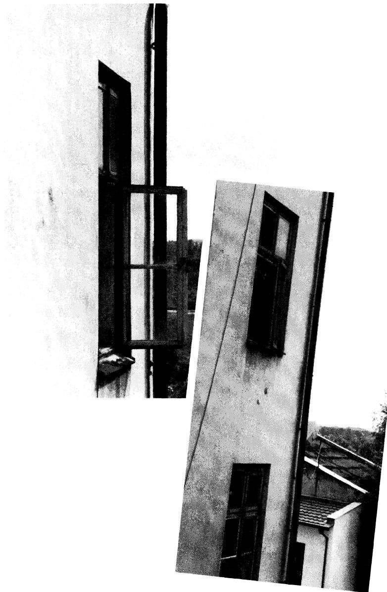
Okna od strony południowo-zachodniej
