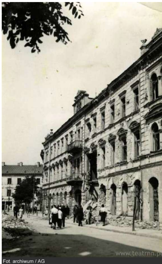
Widok na kamienicę przy ul. Kapucyńskiej 2. Widoczne znaczne uszkodzenia powstałe podczas walk w lipcu 1944 r. Kamienica została wyremontowana i istnieje do dzisiaj
