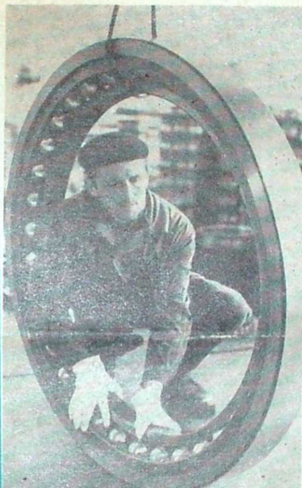
Ryszard Sikora przy montażu łożyska wielkogabarytowego w KFWM. O problemach zarządzania w KFWM piszemy na str. 6. Fot. J. Trembecki (CAF)
