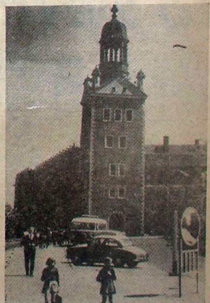
... i po odbudowie
