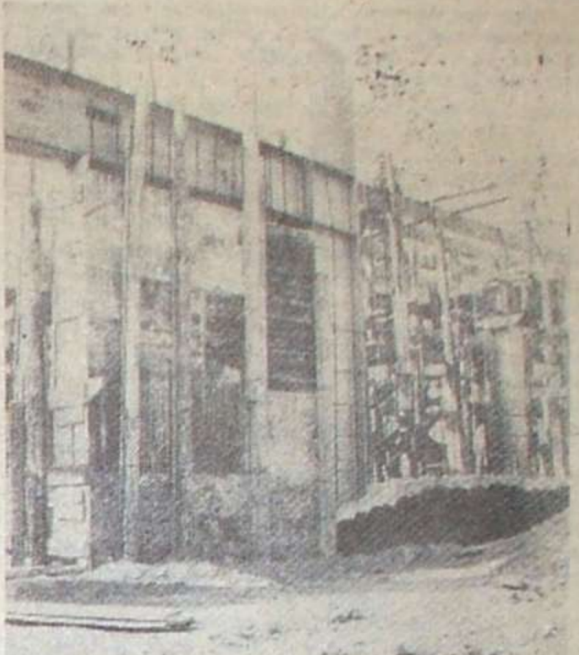
Na placu budowy nowego teatru dramatycznego
