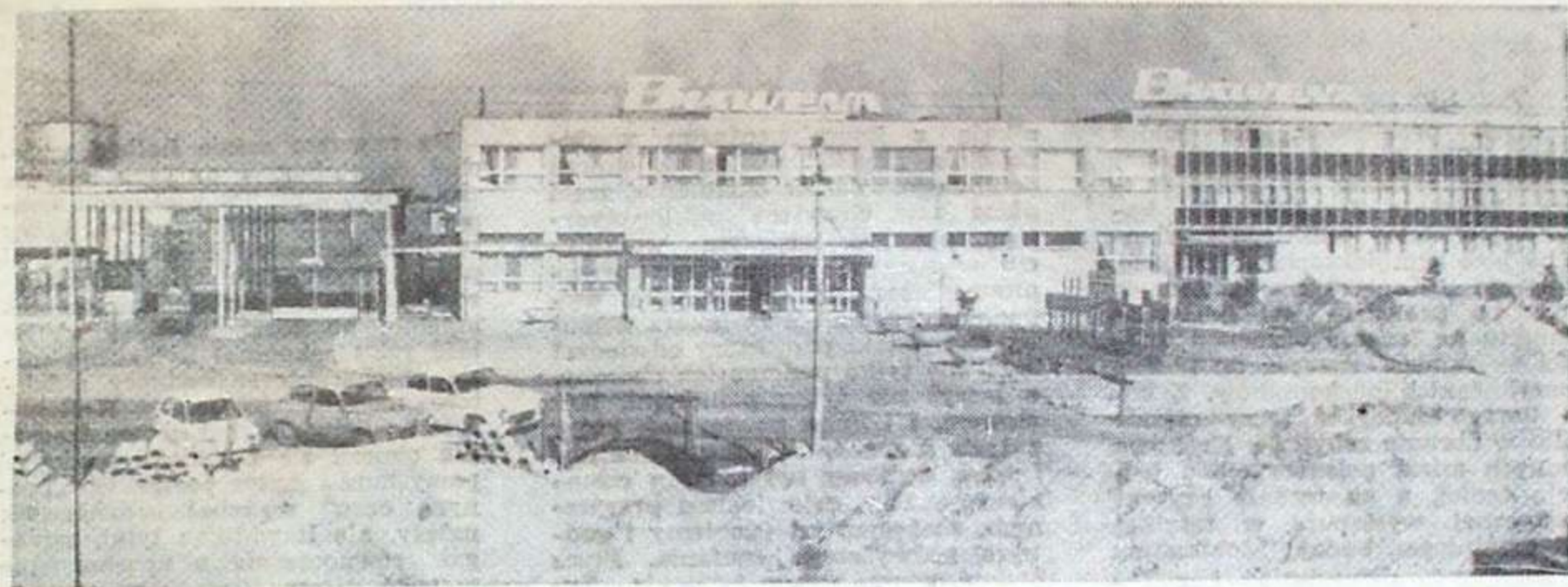
Ogólny widok zakładu
