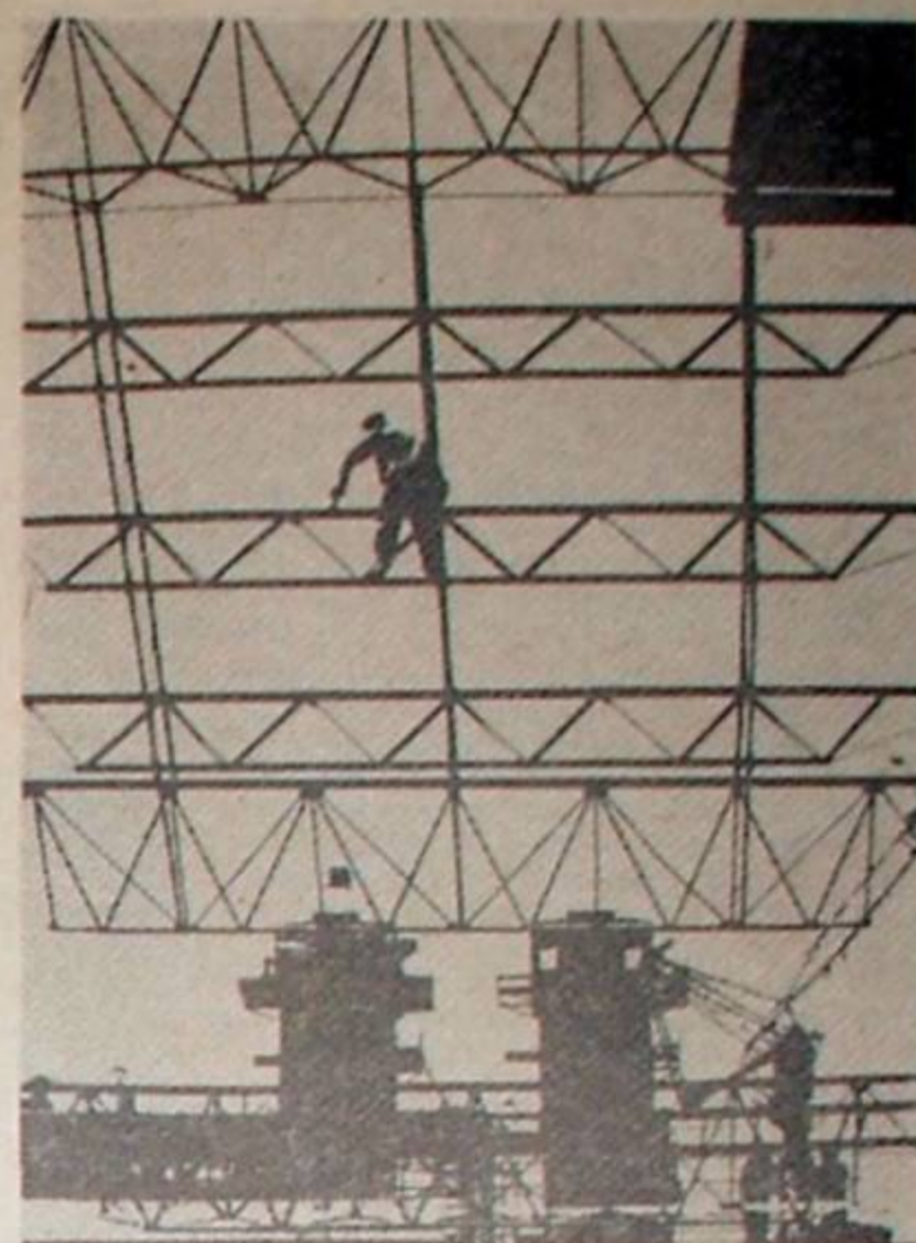
Budowa Cementowni Chełm II
