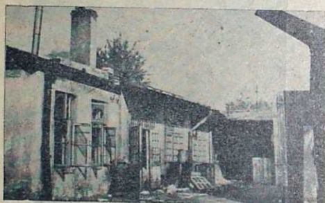
Wejście do dawnej hali maszyn
