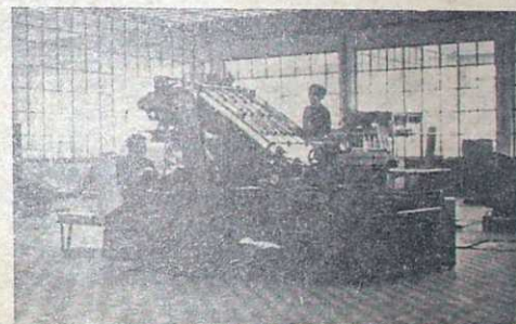
Obecna hala maszyn
