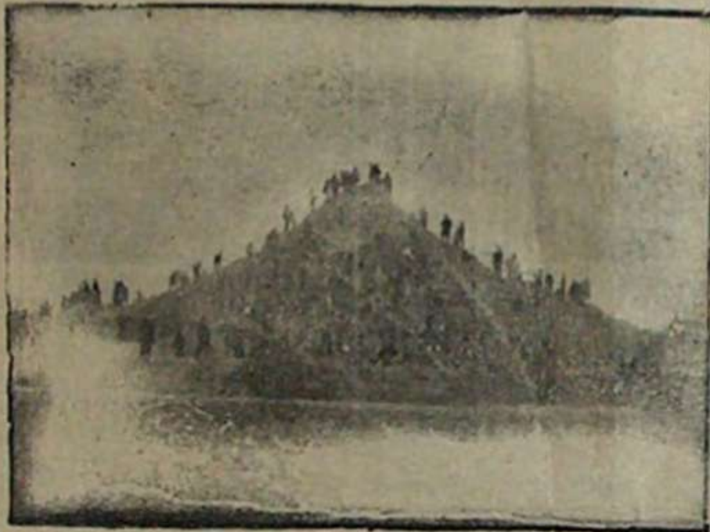
Na ilustracji naszej widzimy budowę kępcy w Płowcach
