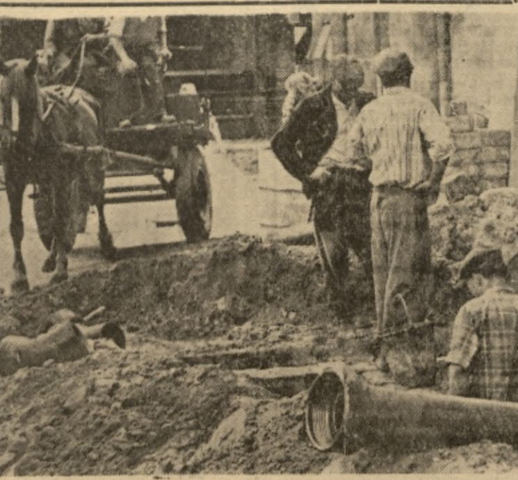
Stare Miasto otrzymuje nową sieć kanalizacyjną i wodociągową. Obecnie do wszystkich kamieniczek, którym nie zagraża obsunięcie się fundamentów doprowadzane są nowe przewody...
