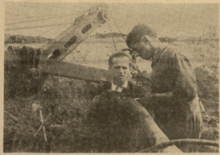
Grupa techniczna kończy ostatnie przygotowania do uruchomienia pompy ściągającej wodę.
