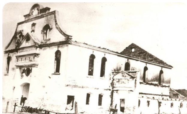
Fot. Synagoga po pożarze w 1938r.
