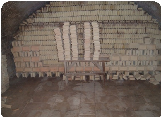
Fot. Wnętrze pieca.
