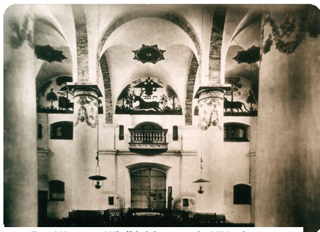
Fot. Wnętrze Wielkiej Synagogi z XIX wieczną polichromią.
