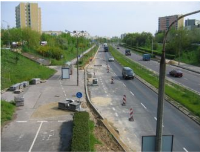
Droga rowerowa i przystanek – miejsce szczególnie niebezpieczne.
