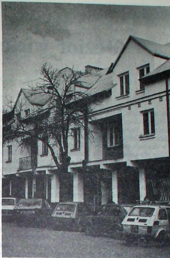
Fragment budynku przy ul. Lwowskiej 11
