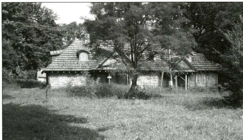
Gałęzów. Dwór w trakcie remontu, stan z 2006
