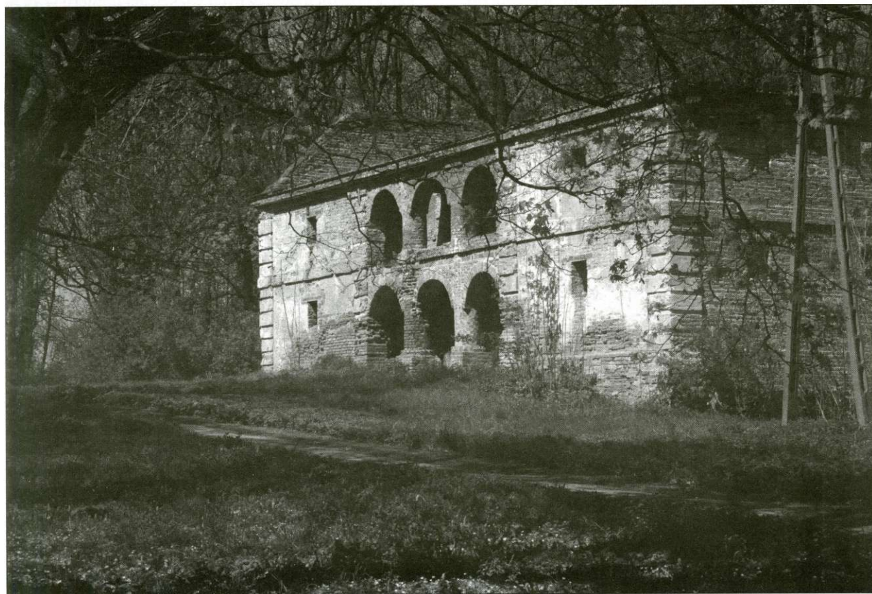
Murowany spichlerz dworski z II połowy XIX w., widok od strony wschodniej - stan obecny
