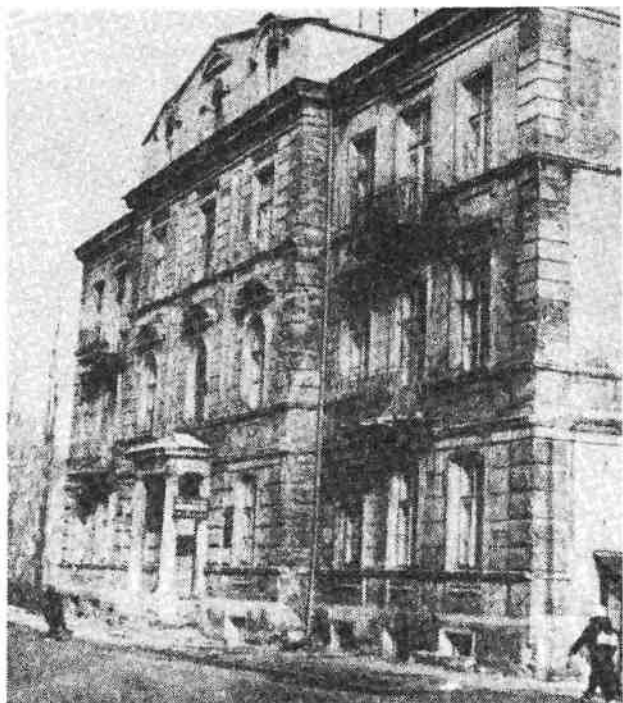
3. Niecała 3 (dziś Georgi Dymitrowa) — gmach dawnego Gimnazjum Koedukacyjnego przy Towarzystwie Zakładania Szkół Żydowskich
