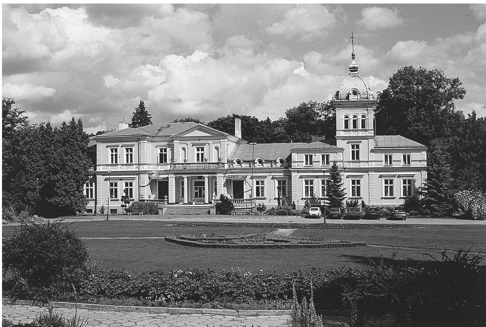
1. Kluczkowice, pałac Kleniewskich, elewacja frontowa; fot. Michał Trzewik, 2000 r.
