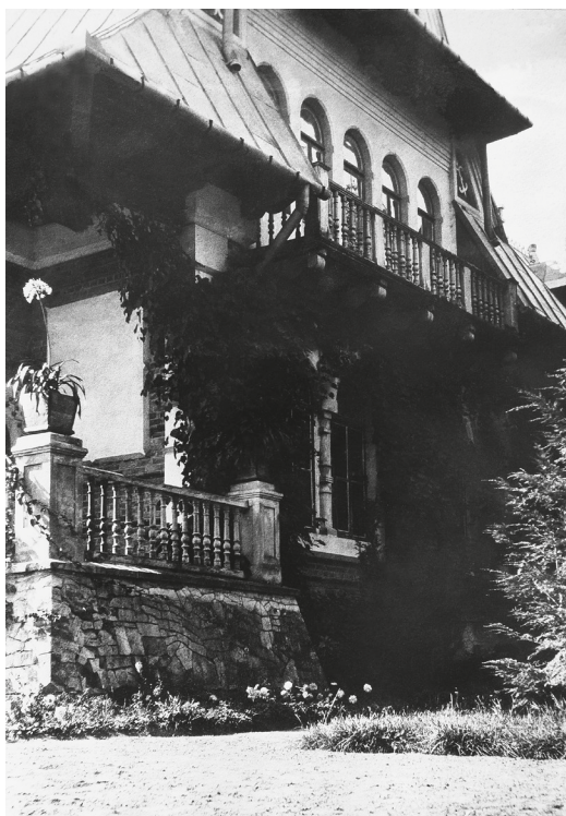
13. Łańcuchów, widok na elewację boczną, północną, dworu, 1904 r. Repr. fotografii należącej do Andrzeja Jastrzębskiego.
