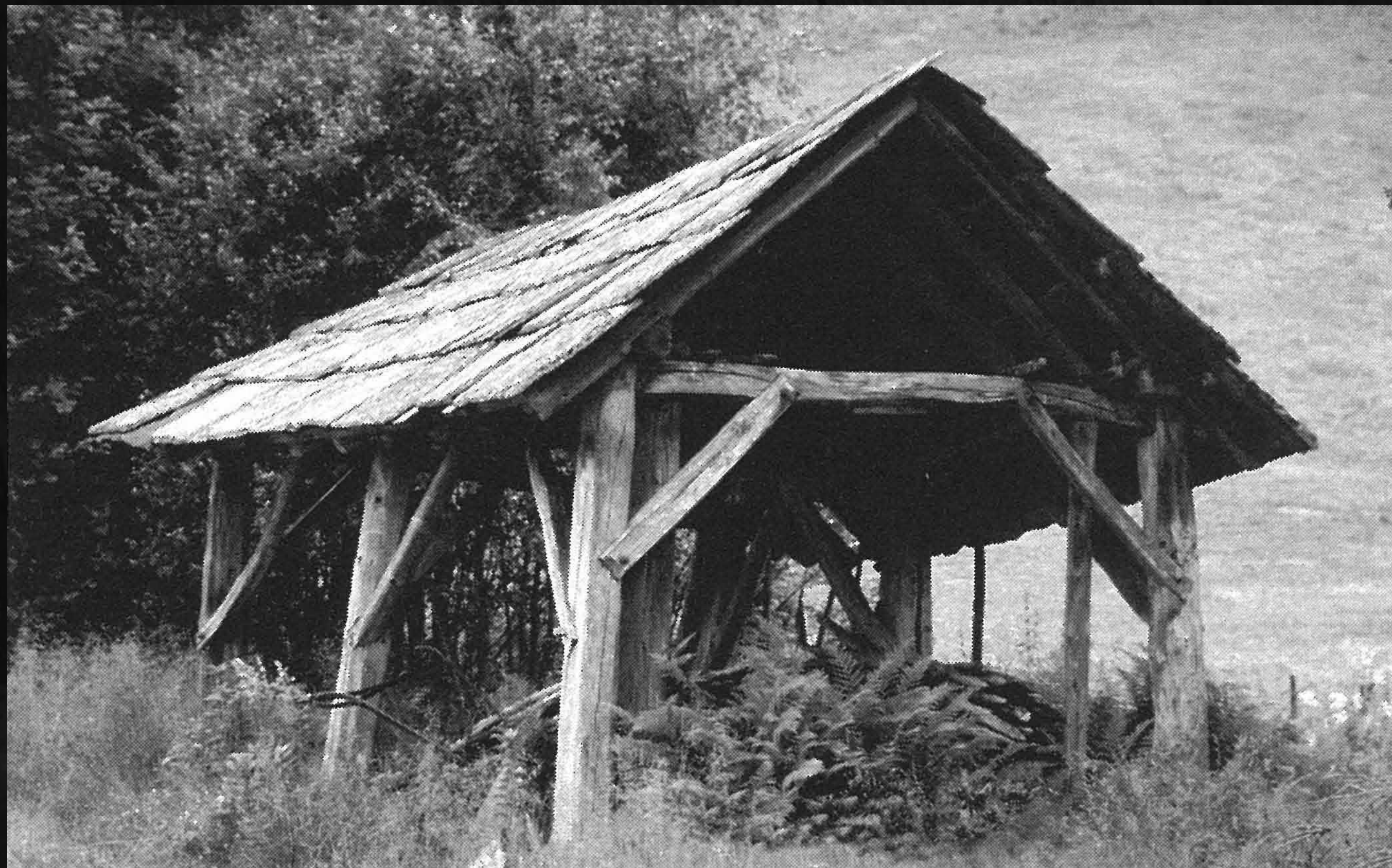
Budynek o konstrukcji ramowej z gminy Øystese, hrabstwo Hordaland, fot. Helge Schjelderup
