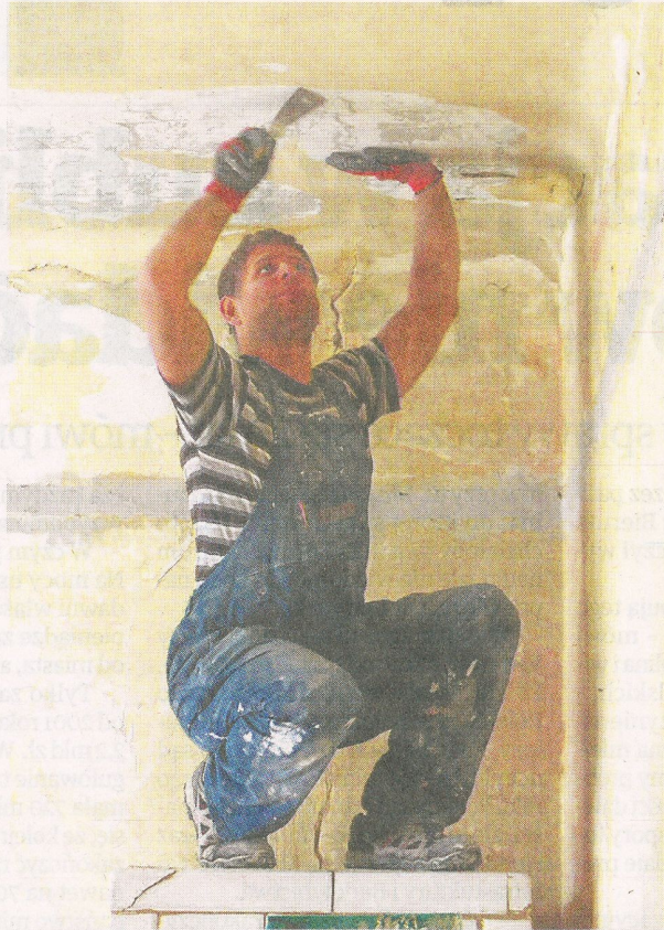
► Remont prowadzony pod hasłem Mieszkanie Kultury odbywa się na Żmigrodzie z inicjatywy Domu Słów - Teatr NN
