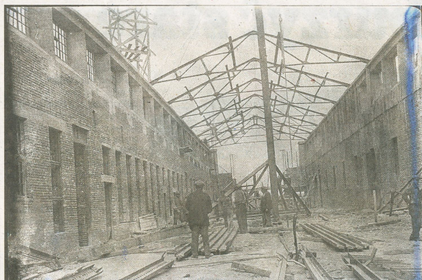
► Budowa rzeźni miejskiej przy ulicy Turystycznej w Lublinie
