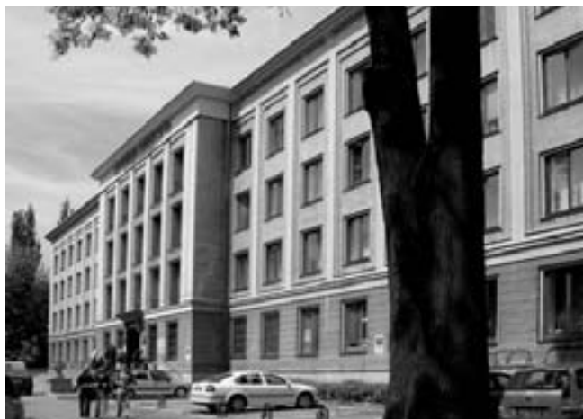
Powojenny budynek byłego Komitetu Wojewódzkiego PZPR przy Al. Racławickich. Obecnie Akademia Medyczna. Fot. M. Skrzypek.
