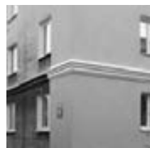
Fragment budynku na osiedlu ZOR-y przy ul. Pułchacza z częściowo ocieploną i odnowioną elewacją. Fot. M. Skrzypek.
