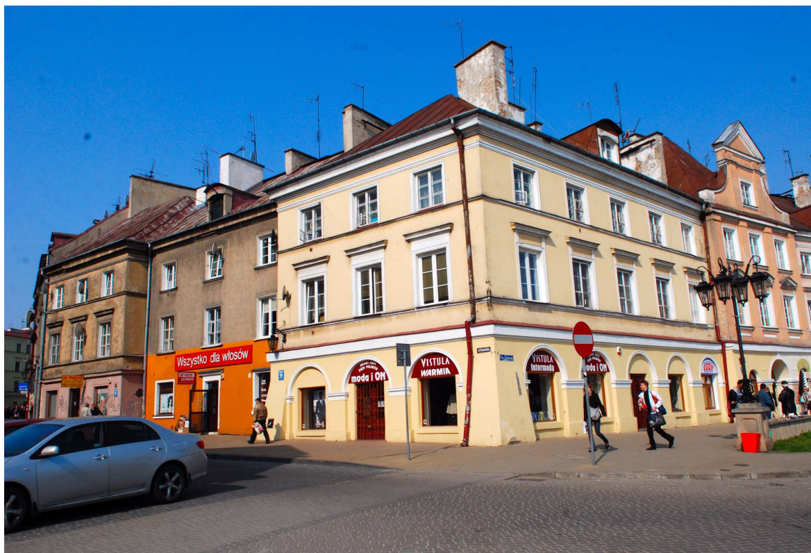
Elewacja główna i boczna, Kowalska 16, fot. Marcin Moszyński, 2010.
