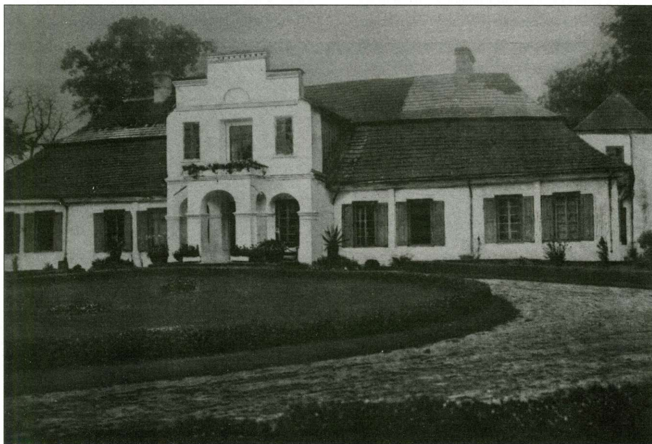
Osiemnastowieczny drewniany dwór w Kluczewsku. Zbudowany dla Turskich, do 1944 roku własność Konarskich. Po 1945 roku urządzone tu skład nawozów sztucznych. W 1960 roku dwór rozebrano
